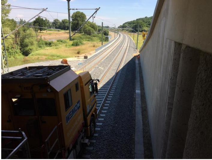
Bauwerksprüfung – BAB A73 Tunnel Unterberndorf
