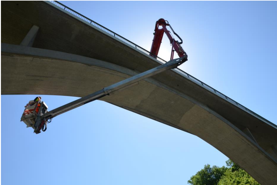
Bauwerksprüfung einer Bogenbrücke, BAB A70
